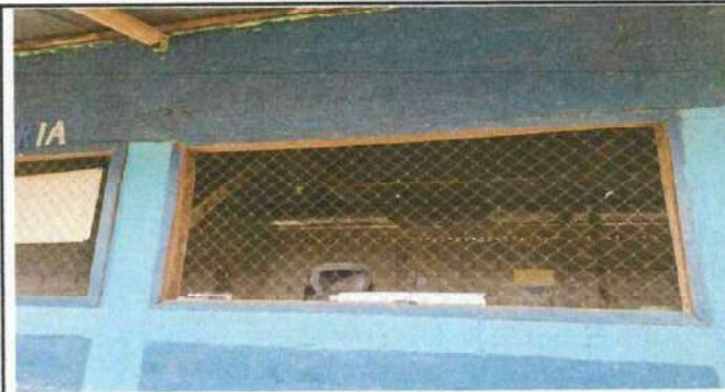
Foto 6: VENTANAS DE MADERA EN MAL ESTADO
