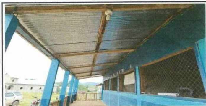
Foto 5: VENTANAS DE MADERA CON MALLA EN MAL ESTADO
